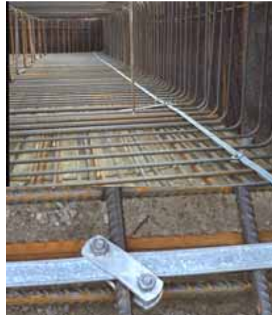
Bild 25: Anschluss der Erdungs-Stahlbands am Armierungseisen
