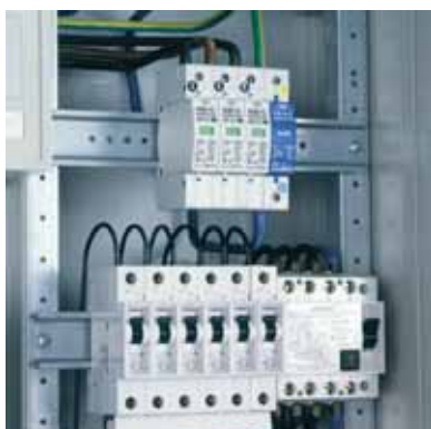
Bild 50 Überspannungsschutz (Obo Bettermann)
