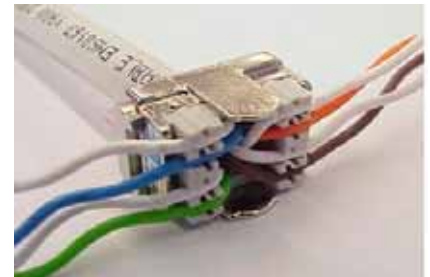
Bild 61: Drähte bereit für Anschluss
