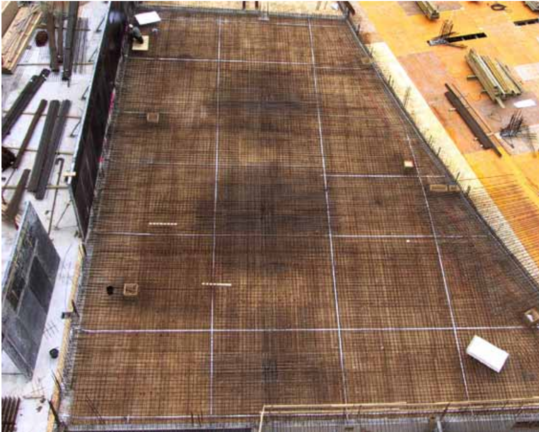
Bild 36: Anschluss von Erdungssystem an Armierungsstahl für vermaschtes Potentialausgleichskonzept (Obo Bettermann)
