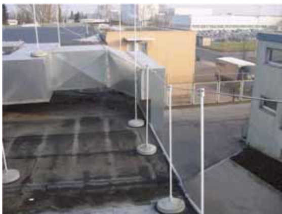
Bild 44: Fangstange auf einem Flachdach (Obo Bettermann)
