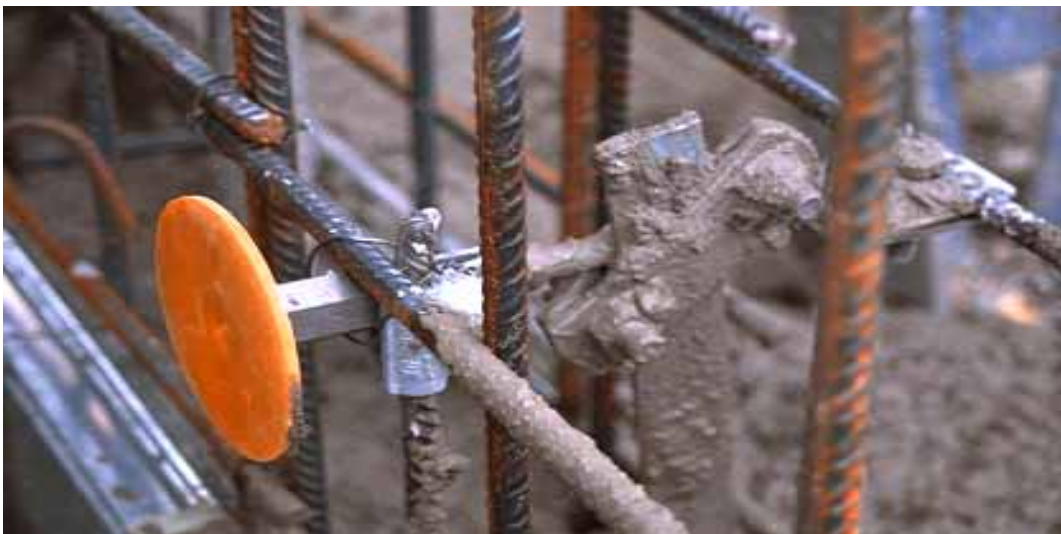
Bild 37: Potentialausgleichspunkt während der Bauphase. (Obo Bettermann)
