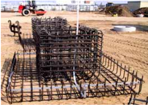
Bild 24: Armierungseisen mit Stahl-Bändern geerdet.
