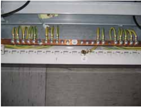
Bild 73: Panels mit Anschluss-Schiene verbunden
