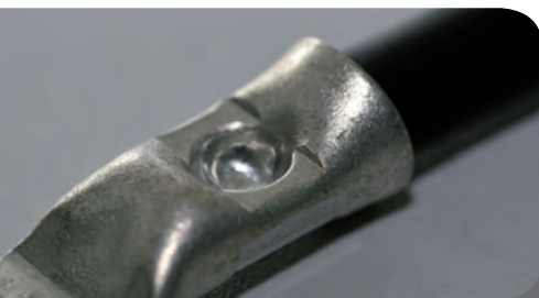
Fachgerecht verpresster F-Kabelschuh mit einer Dornpressung
